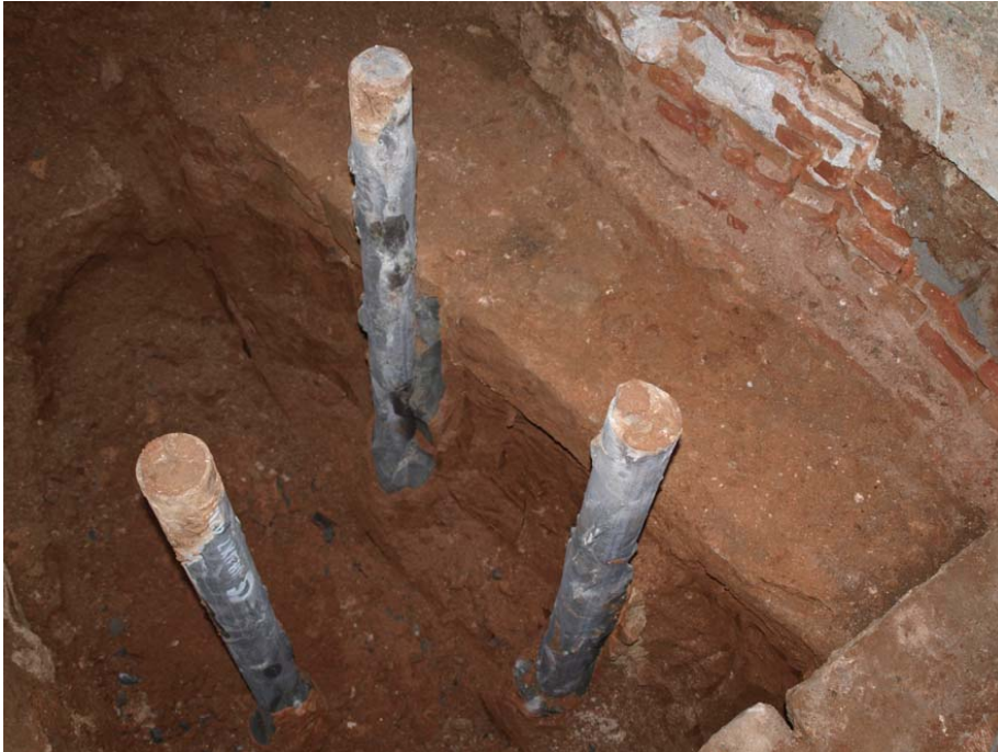
Estruc, 4: encepats 4, mur UE 405.
