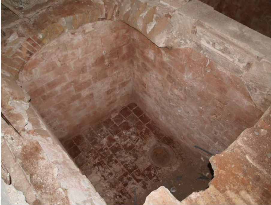
Comtal, 13: paviment d'un dels dipòsits amb el gibrell de decantació.
