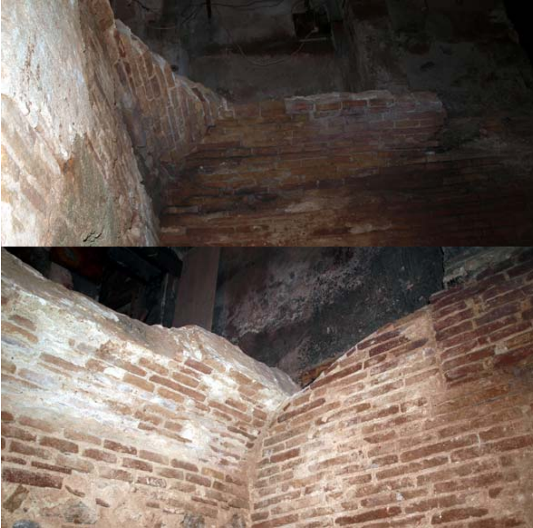
Estruc, 6: arrancament de les voltes. A dalt: volta esquifada; a baix: volta escarsera.
